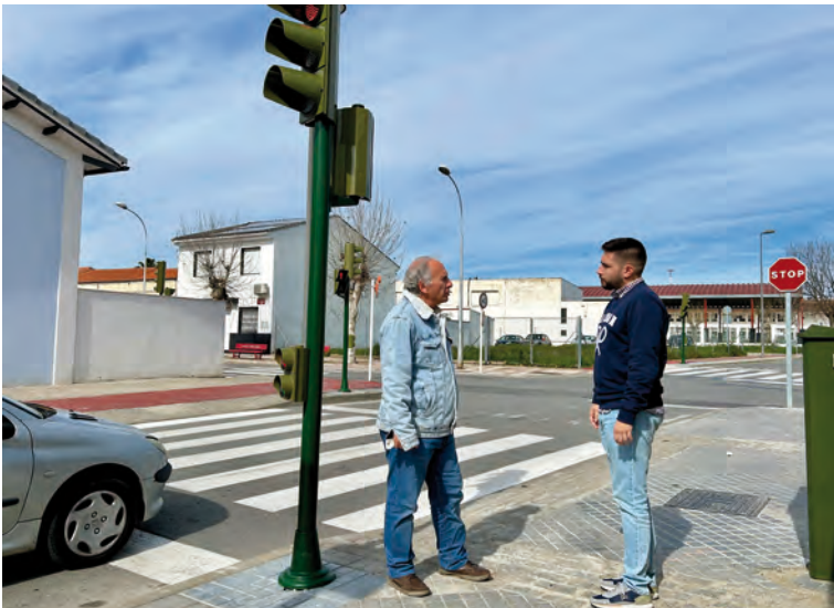
Semáforos que se han instalado en la zona de conexión de las rondas norte y sur
