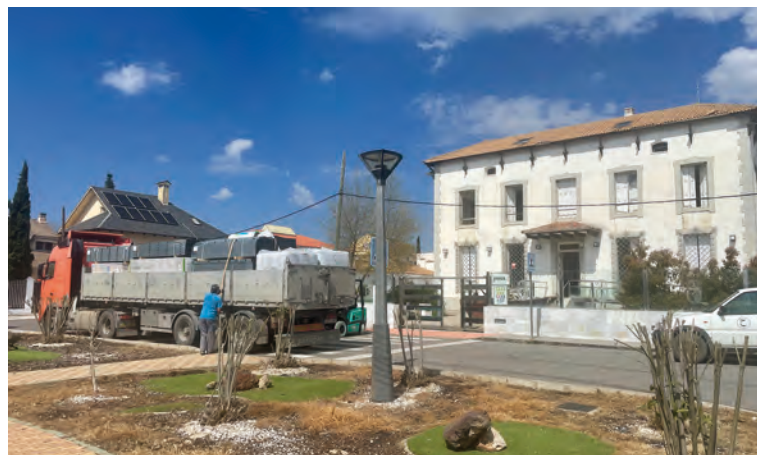
Instalaciones que albergarán el centro sociosanitario
